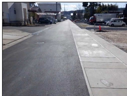
排水路整備（喜多町）
