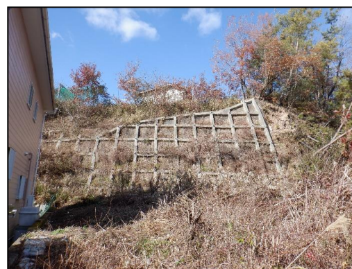
急傾斜地崩壊対策工事（小泉地区）
