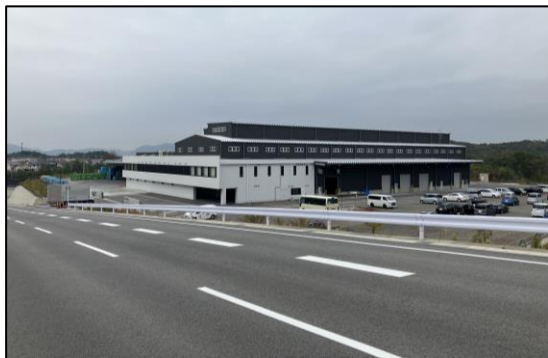
市道315434線(土岐多治見北部連絡道路)
