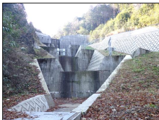
砂防えん堤の整備（月見町）
