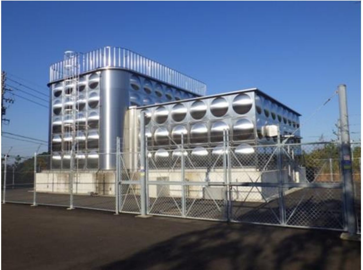
脇之島送水ポンプ場 平成 29 年 9 月完成
