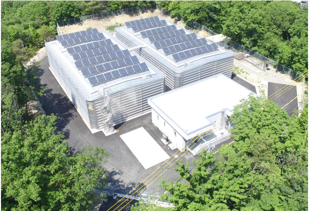
虎溪山配水池 平成28年3月完成
