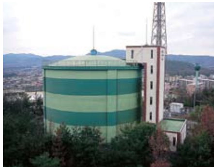
あさひがおかだい はいすいち 旭ヶ丘第2配水池 おなだちようせいはいすいち おく 小名田調整・配水池から送られてくる 水をためて、旭ヶ丘、明和方面の家庭 に給水します。
