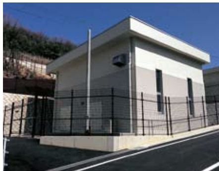
おなだきたはいすいじよう 小名田北配水場 おなだちようせいはいすいち みず 小名田調整・配水池からの水をポンプ で小名田地区の家庭に給水します
