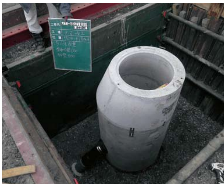
ぜんたいぞう マンホールの全体像
