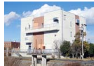
雨水ポンプ場
