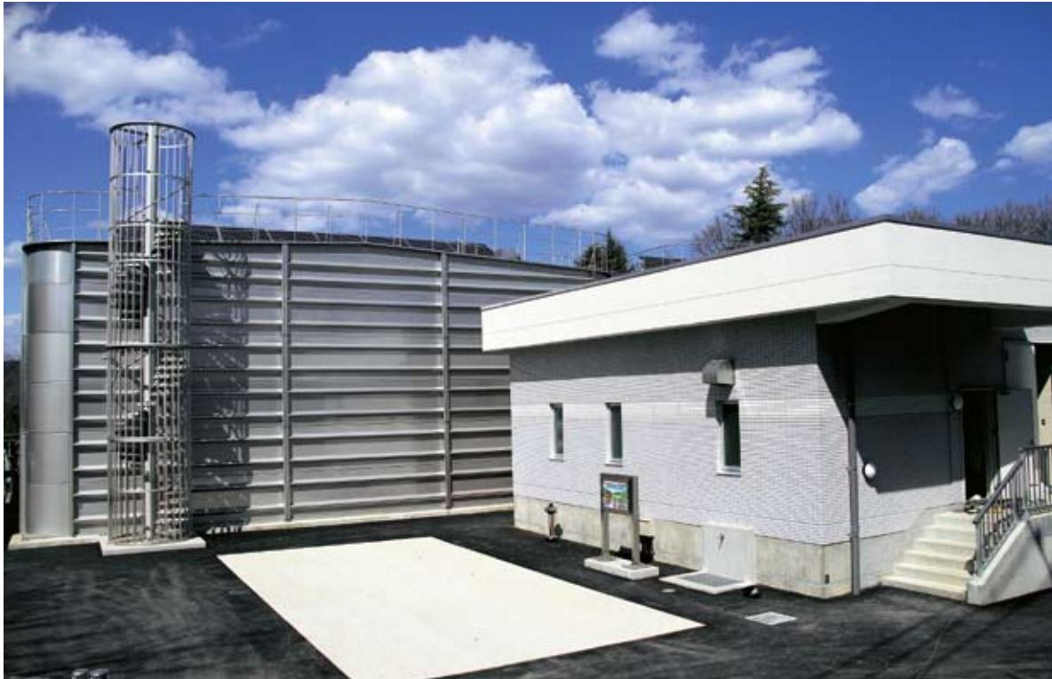
しゃしんひだり はいすいち みぎ きんきゅうじ そうすい どう (写真左：配水池・右：緊急時送水ポンプ棟)
