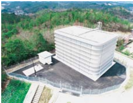
たきろだいはいすいち 滝呂台配水池 たきろじゆすいち おく みず 滝呂受水池から送られてくる水のため て、滝呂台地区の家庭に給水します。
