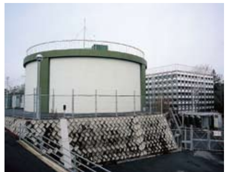
いちのくらはいすいち 市之倉配水池 たきろじゆすいち おく みず 滝呂受水池から送られてくる水のため て、市之倉地区の家庭に給水します。
