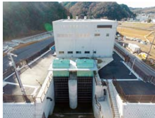
と きがわ さ かん じょう 土岐川左岸ポンプ場
