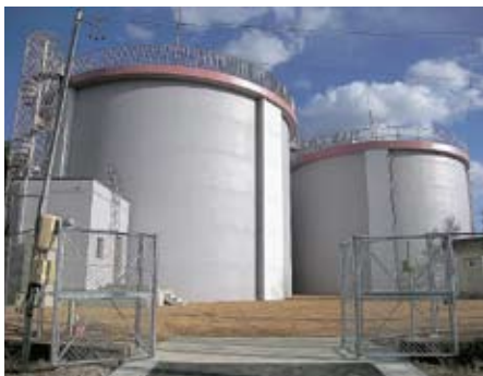
わきのしまだい だい はいすいち 脇之島第1・第2配水池 たきろじゆすいち おく みず 滝呂受水池から送られてくる水のため て、脇之島地区の家庭に給水します。
