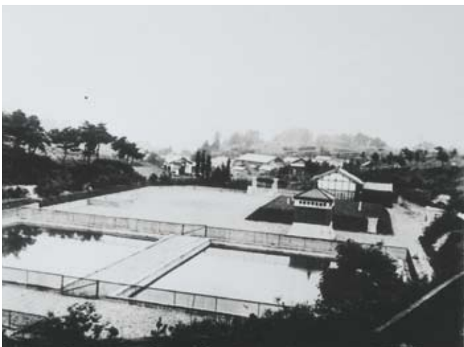
多治見町時代、大正12年に給水を始めた時の浄水場。建物の下に水を貯める水槽があります。
