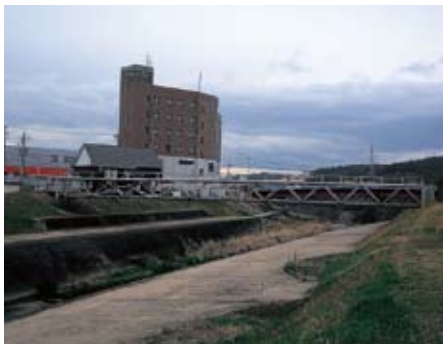
すいかんきよう 水管橋 おおはらかわ か ちよっけい すいかんきよう 大原川に架かる直径30cmの水管橋で す。
