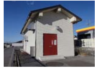
汚水中継ポンプ場
