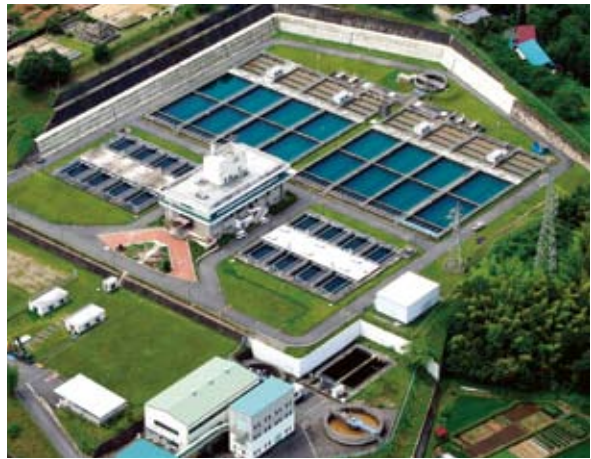
中津川浄水場・ろ過施設 写真提供:岐阜県水道企業課
