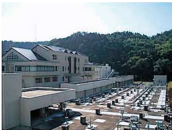
いけだ げすいしよりじょう 池田下水処理場
