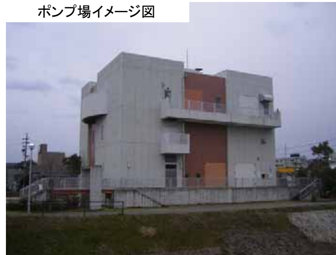
写真は 笠原川右岸ポンプ場
