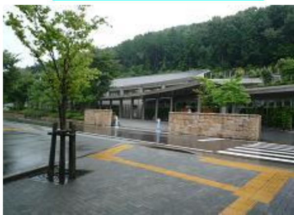
関市総合斎苑わかくさ(H17年建設)
