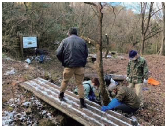
市内ビオトープ修繕の様子
