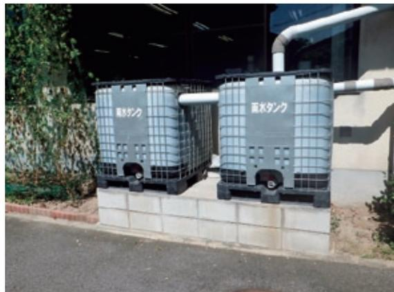
図 2-2-5: 消防本部の雨水貯留タンク(写真)
