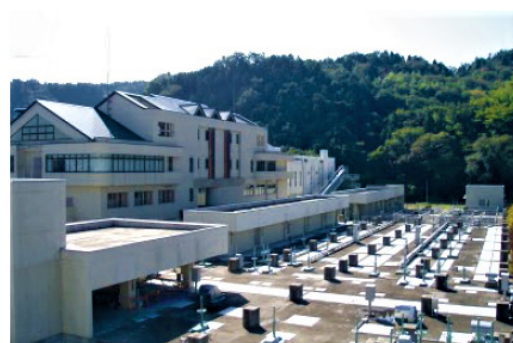
池田下水処理場
