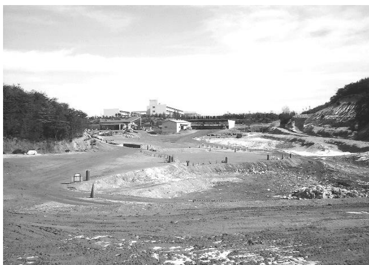
安定型最終処分場
