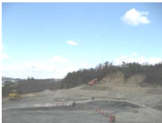
安定型最終処分場
