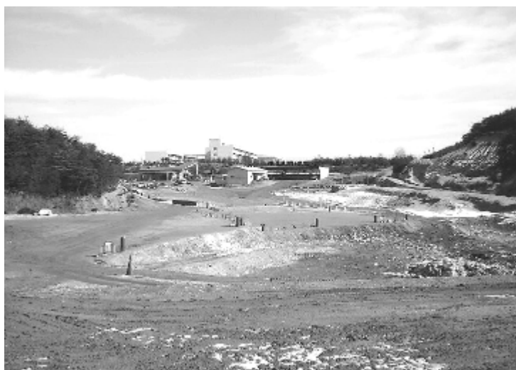
安定型最終処分場
