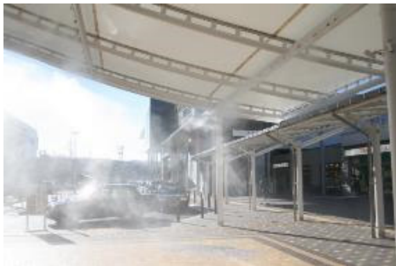
図 2-5-7: 駅南ミスト設置状況(写真)
