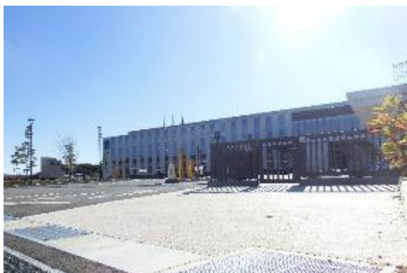
図 2-5-6: クールアイランド舗装(写真)
