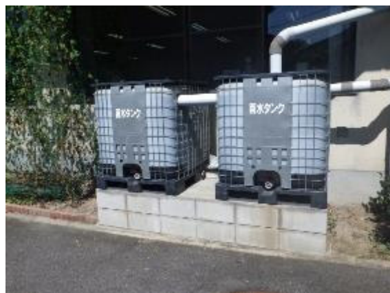
図 2-2-5: 消防本部の雨水貯留タンク(写真)
