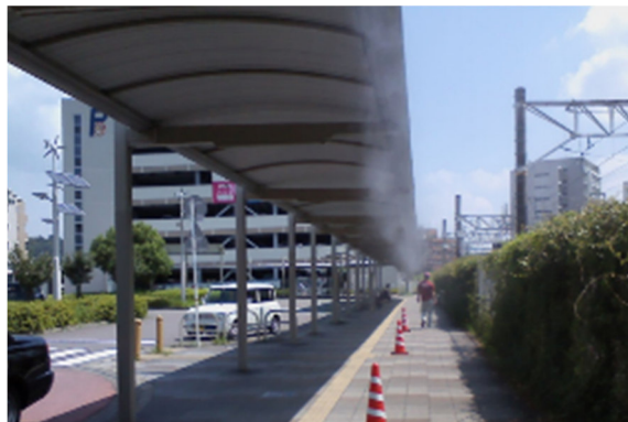
図 2-5-8: 駅北ミスト設置状況(写真)
