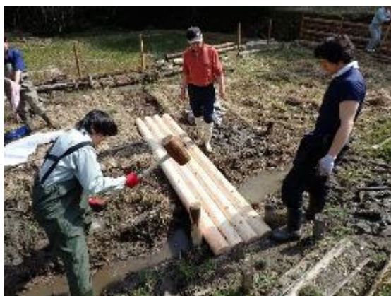
図 2-3-13: 市内ビオトープ修繕の様子(写真)
