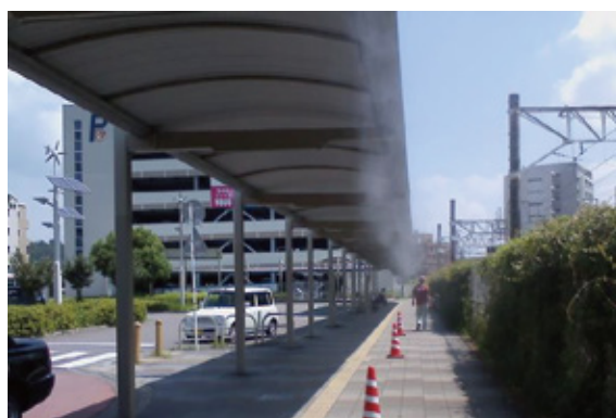
図 2-5-6 : 駅北ミスト設置状況 (写真)
