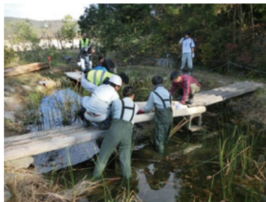
図 2-3-11：市内ビオトープ修繕の様子（写真）
