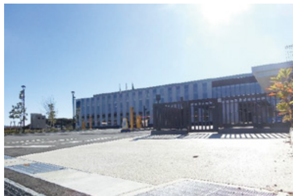
図 2-5-4 : クールアイランド舗装 (写真)
