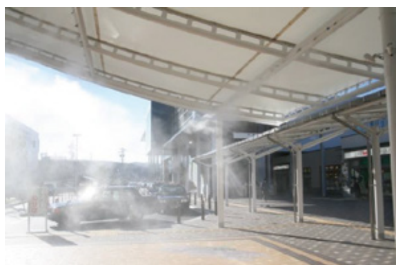
図 2-5-5 : 駅南ミスト設置状況 (写真)
