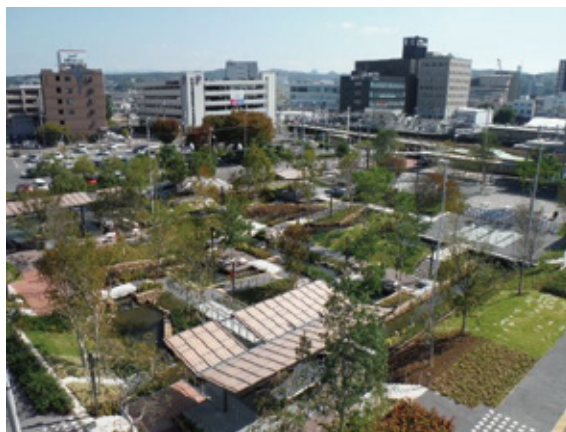
図 2-5-3：虎渓用水広場（写真）
