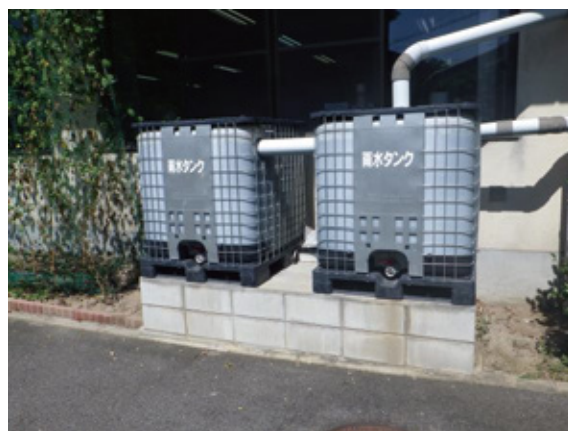
図 2-2-4 : 消防本部の雨水貯留タンク (写真)
