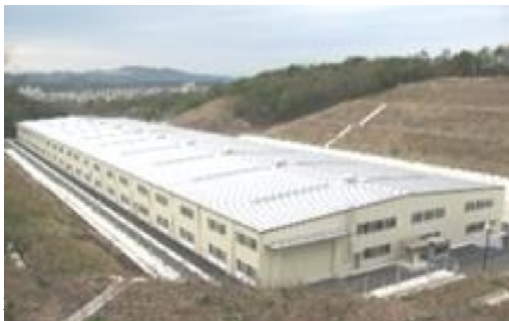
管理型（クローズド型）最終処分場
