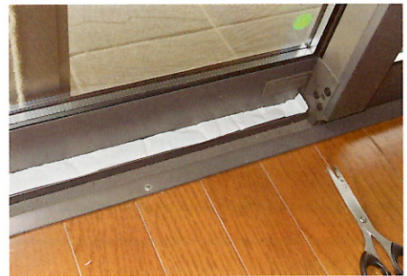
隙間シートで目張り
