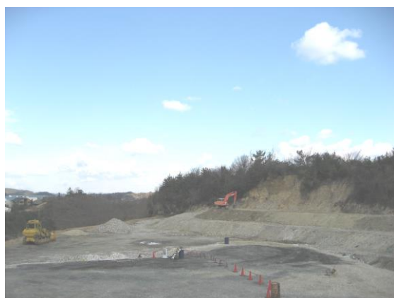
安定型最終処分場
