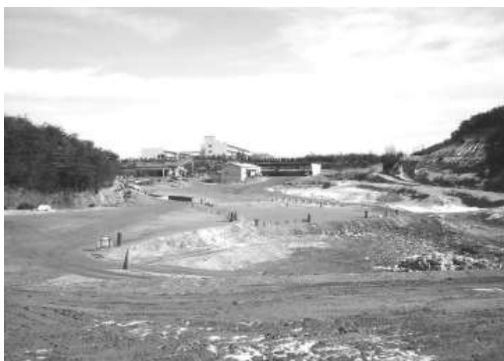
安定型最終処分場
