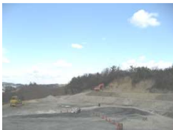
安定型最終処分場
