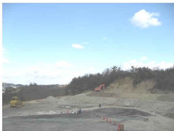
安定型最終処分場
