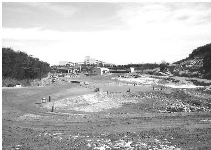
安定型最終処分場
