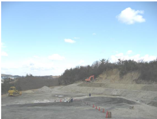
安定型最終処分場
