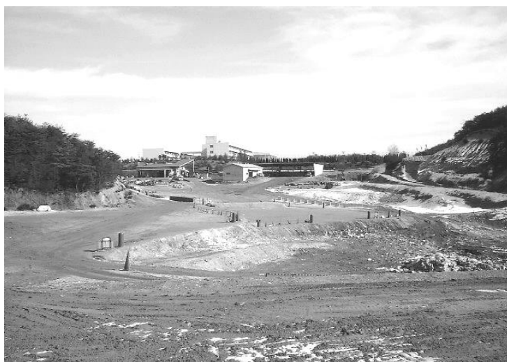
安定型最終処分場
