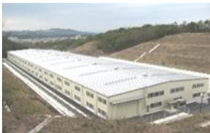
管理型(クローズド型)最終処分場
