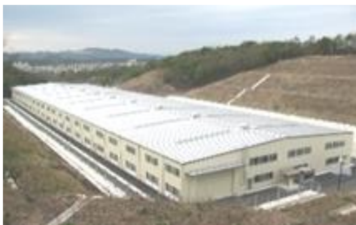
管理型(クローズド型)最終処分場
