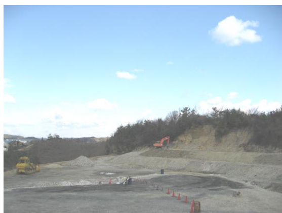
安定型最終処分場
