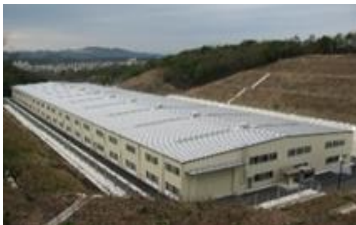
管理型(クローズド型)最終処分場
