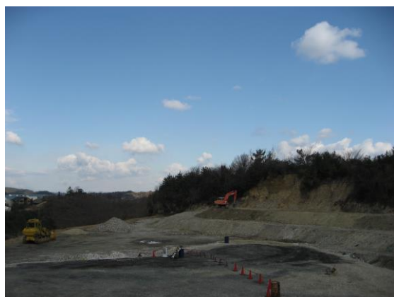
安定型最終処分場
