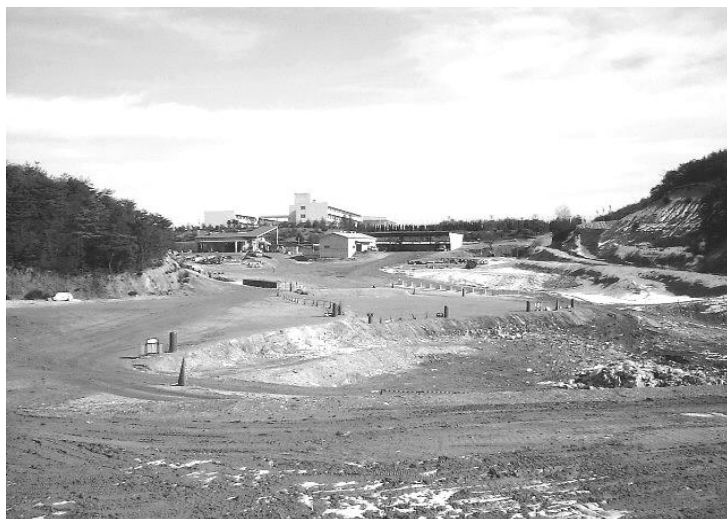
安定型最終処分場
