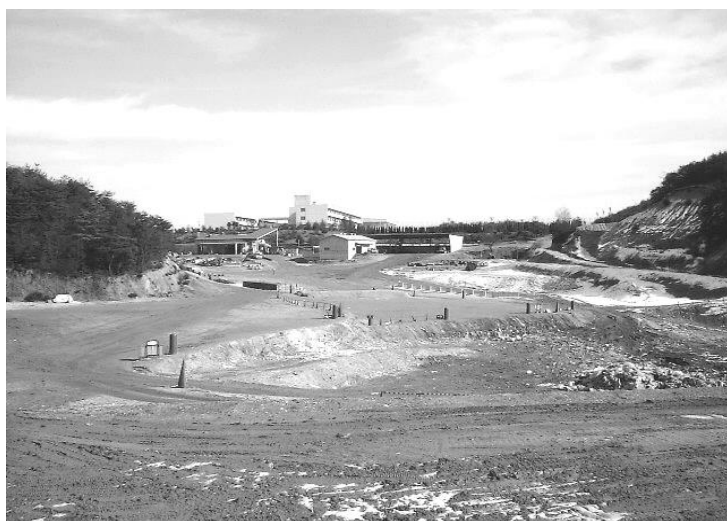
安定型最終処分場
