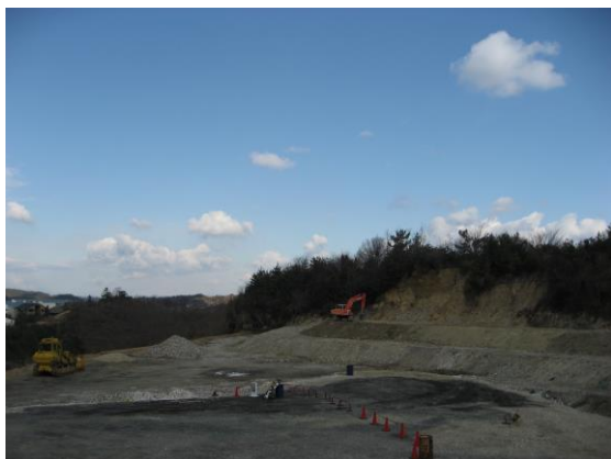
安定型最終処分場
