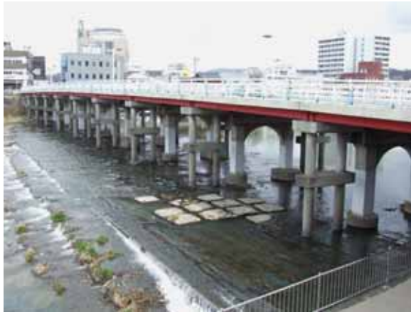
昭和橋：橋長 116.2m 架設年度 昭和 2 年
