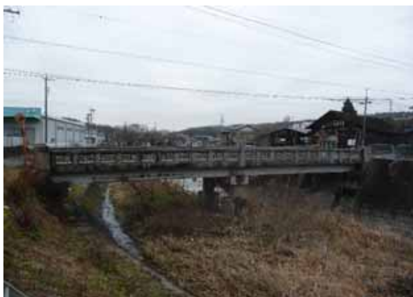
滝呂中央橋：橋長 24.2m 架設年度 昭和 13 年
