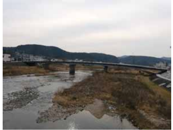
陶都大橋：橋長 146.4m 架設年度 昭和 43 年
