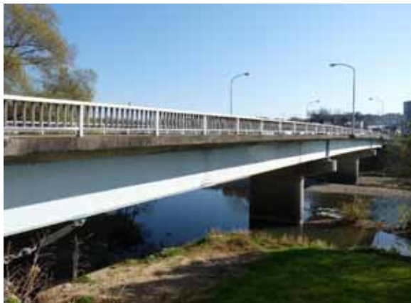
記念橋：橋長 106.8m 架設年度 昭和 46 年
