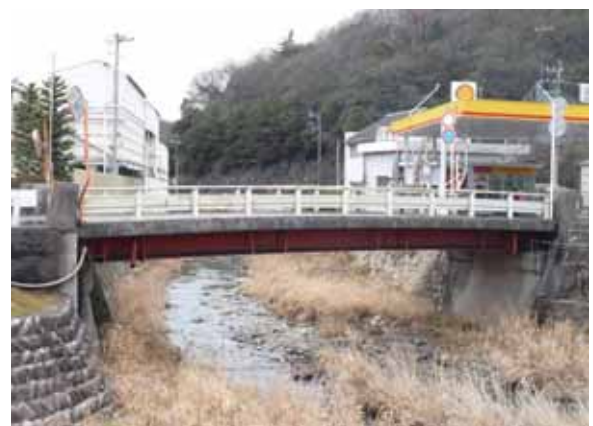
川尻橋：橋長 15.4m 架設年度 昭和 40 年
