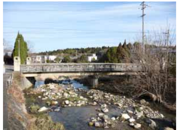
大坪橋：橋長 22.2m 架設年度 昭和 8 年
