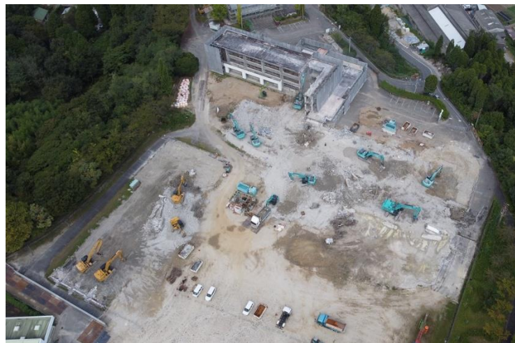
解体工事(笠原小学校内)
