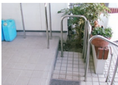
住宅改修 (手すりの設置や段差の解消など)
