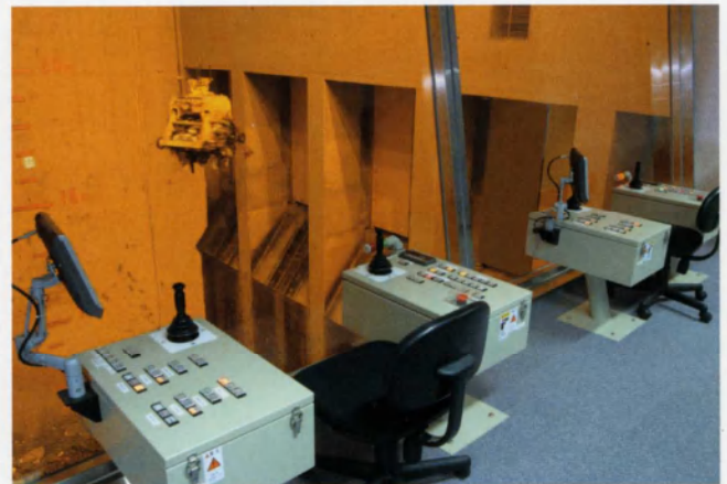
■ごみクレーン操作室 自動運転・手動運転の両方が可能です。
