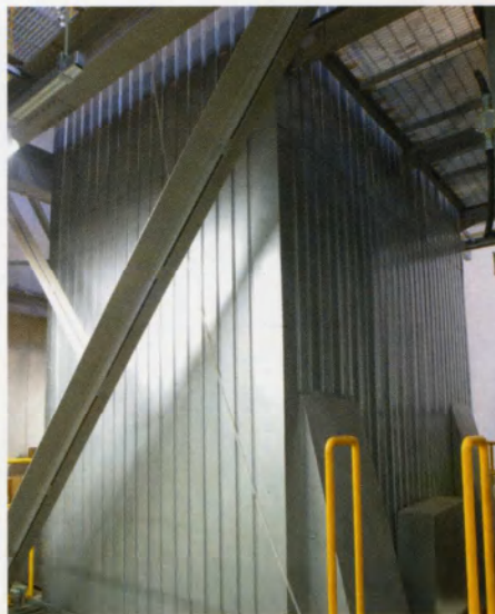
■触媒反応塔 排ガスにアンモニアガスを吹き込み、窒素酸化物(NOx)を分解します。
