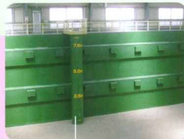
漏水検知ピット
