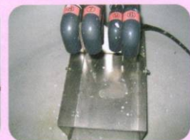
漏水検知ピット
