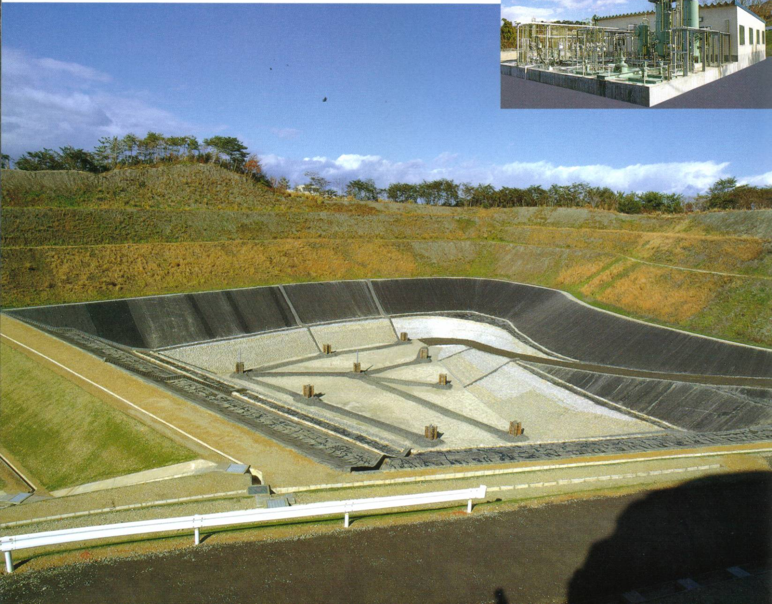
● 埋立処分地全景
