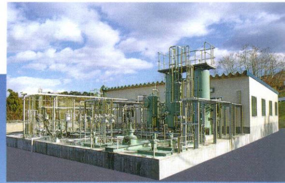
● 浸出水処理施設
