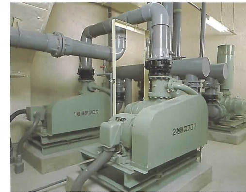
●曝気プロフ 微生物が活発に繁殖できるように、汚水中に空気を送り込む装置です。
