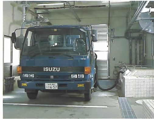
●受入室 し尿と浄化槽汚泥は、それぞれの受入口に投入します。室内の臭気が外部に拡散しないよう、常にファンで吸引しています。
