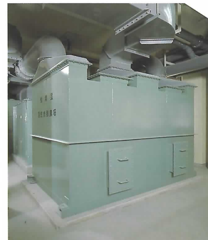
●低濃度臭気脱臭設備 受入室などの低濃度臭気は、活性炭による吸着脱臭処理を行います。
