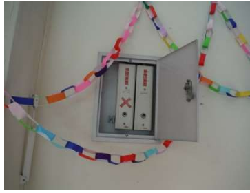
1-2 排煙窓 オペレーターの故障
