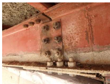
3-1 鉄骨材の錆
