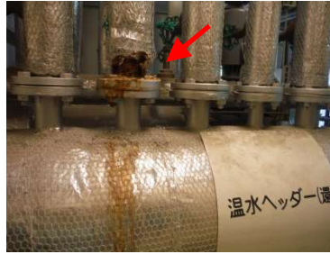
1-5 配管漏水
