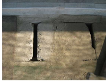
4-1 側溝の破損
