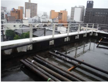
遠景: 施設のどの部分かわかるように撮影
