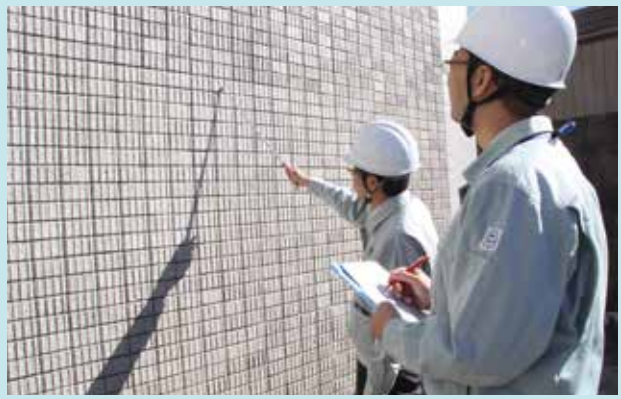
▲外壁タイルが剥がれ落ちないように、日常点検(外壁打診調査など)や予防保全を行っています。
