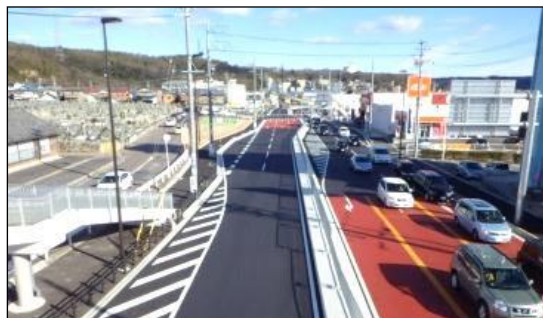
国道 248 号線多治見バイパスの 4 車線化
