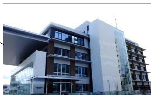
多治見市役所駅北庁舎
