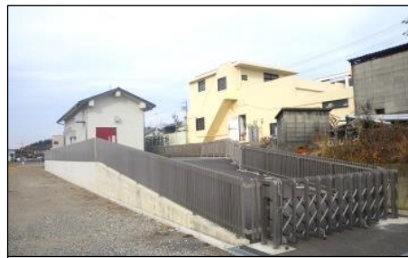
姫第1汚水中継ポンプ場
