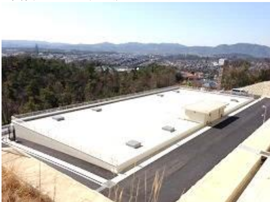
図表 3-84 小名田調整配水池
