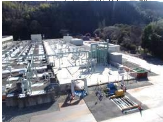
図表 3-85 池田下水処理場高度処理施設
