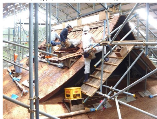
図表 3-15 修繕中の国宝永保寺観音堂
