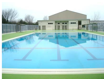
図表 3-10 南姫小学校プール整備
