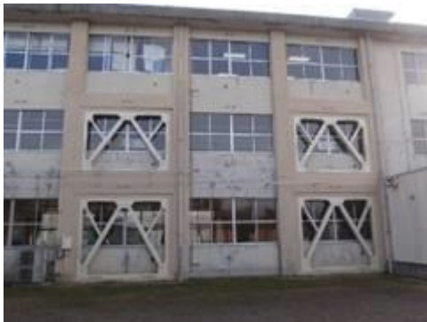
▲根本小学校 耐震補強工事(H21) 小中学校耐震補強工事(H20～H27)で12校 を計画、H22で5校完了
