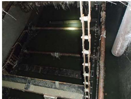
① 揚砂装置の故障(池田)
