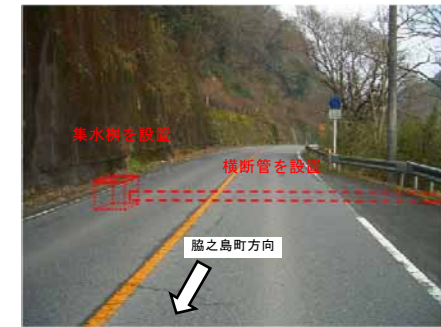
【(主)名古屋多治見線 排水対策】
