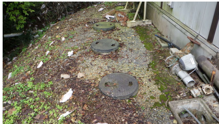
しいたけ栽培施設 浄化槽 W0.9m×D2.7m×H1.5m
