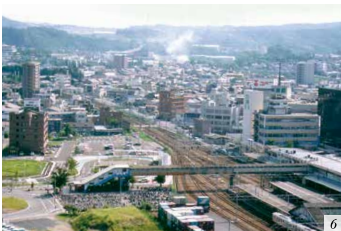
6 平成19年ごろのJR多治見駅(北西から撮影)。当時は、駅南側の地上階に改札口があり、駅北からの利用者は大変不便な思いをしていた。JR多治見駅の橋上化と一体に南北自由通路が整備され、現在は、多治見の玄関口として快適な歩行空間が確保されている。
