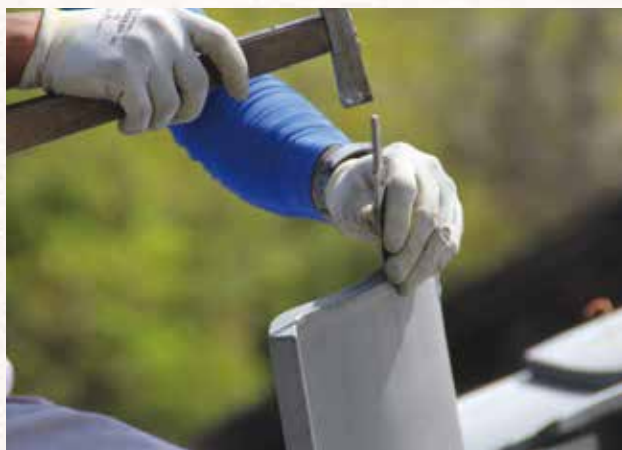
▲鑿（瓦葺き用の鑿）を使い瓦の形状を整える成田さん。伝統工法を守り続ける
