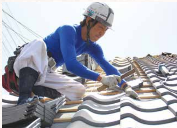
▲耐震強度を上げるため、今は土葺き工法ではなく重量を軽減するため引っ掛け葺き工法が多い
