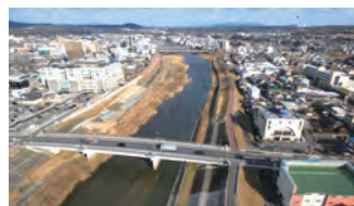
▲テトラポットの無くなった国長橋左岸
