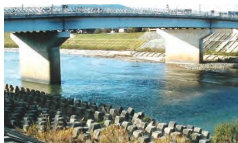
▲テトラポットなど大きな隙間がある2000年頃の国長橋左岸
