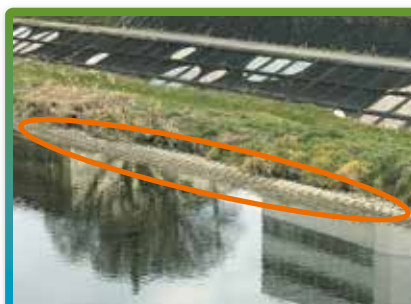
▲ 昭和橋上流のコンクリート製の護岸
