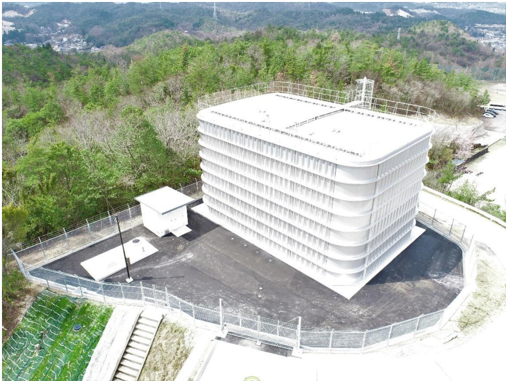
滝呂台配水池 令和3年2月完成
