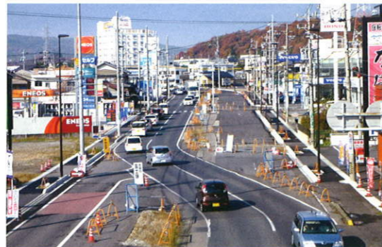
▲ 国道248号線多治見バイパス
