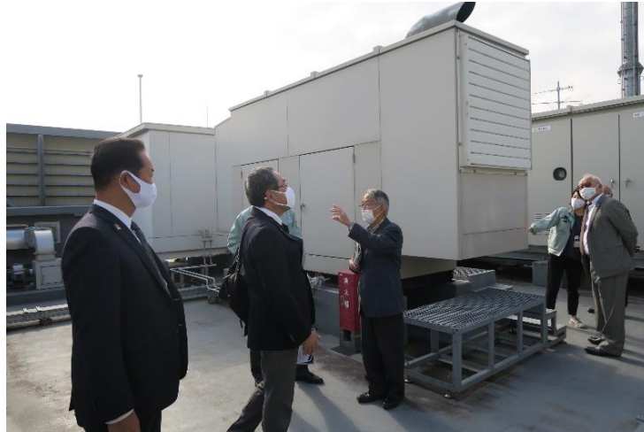
駅北庁舎屋上
