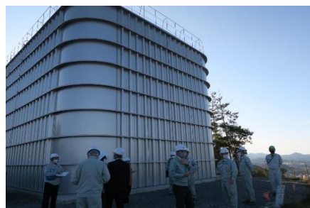
【滝呂台配水池現地視察】
