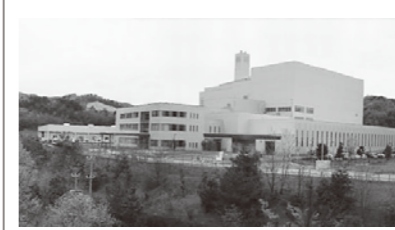
長寿命化工事、浴槽炉などの設備の更新などに要した経費
