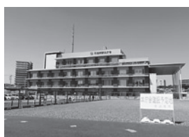
本庁舎建設予定地
